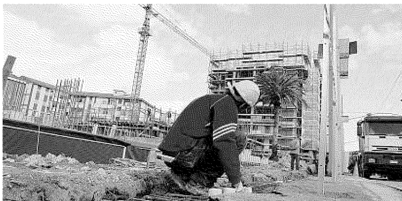
► Impresa edile al lavoro in un cantiere
